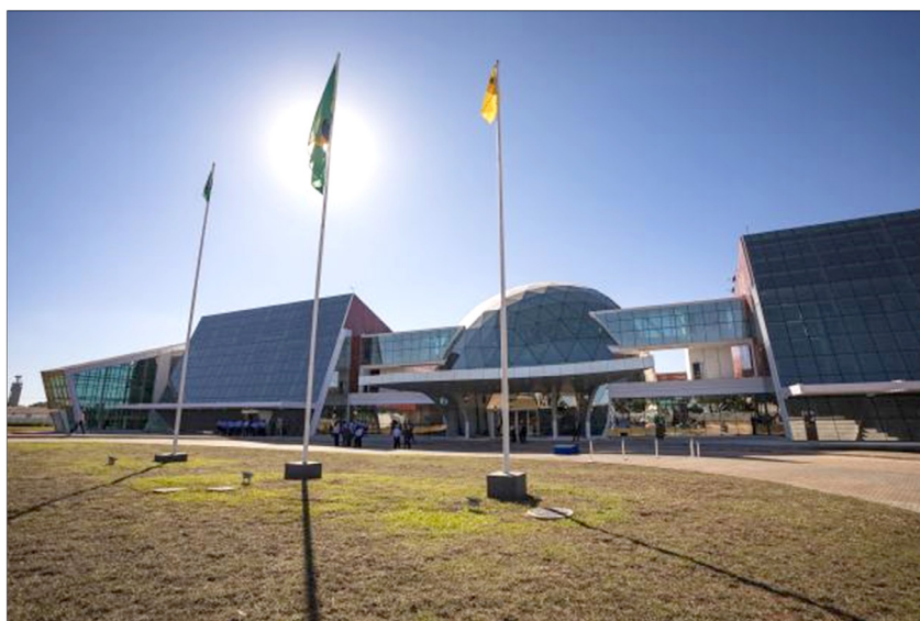
Figura 3. Instalaciones del Centro de Operaciones Espaciales (COPE)
