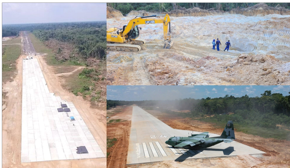
Figura 8. Obras de ampliación e inauguración de la pista Estirão do Ecuador
