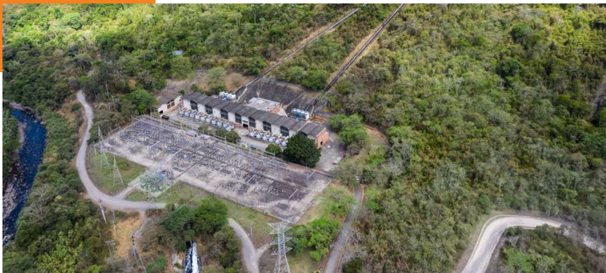
Central de Generación Eléctrica Dario Valencia, Colombia - ENEL
