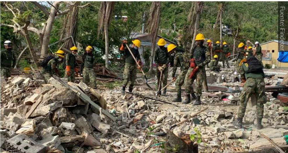
Compactando escombros y nivelando el terreno para instalar cimientos
